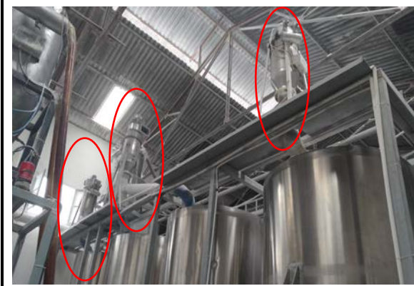
储料罐除尘装置
