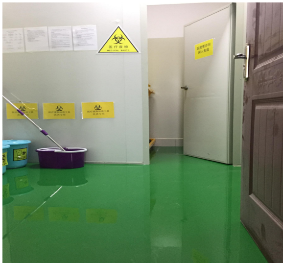
医疗废物暂存间地面防渗及其标识
