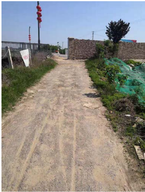
现有堤顶道路现状
