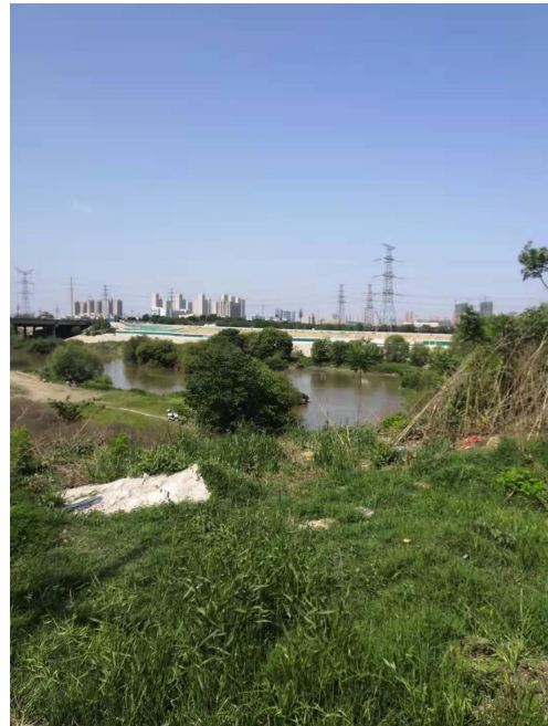
现有河堤现状
