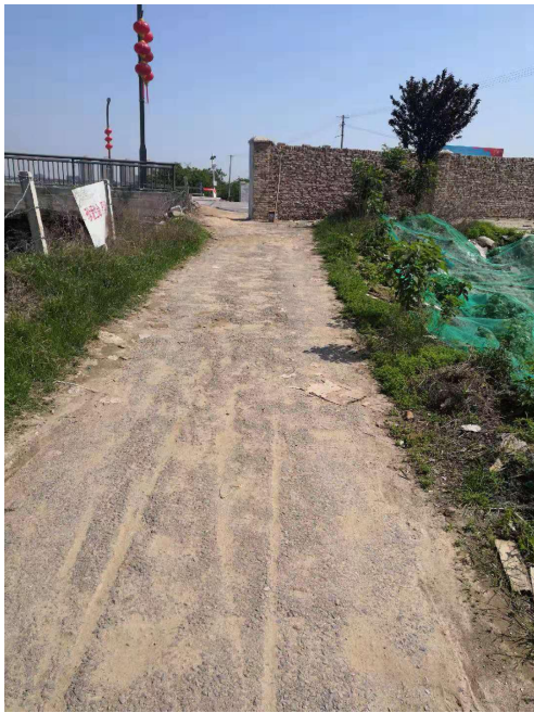
现有堤顶道路现状
