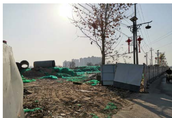
污水处理厂南侧施工空地
