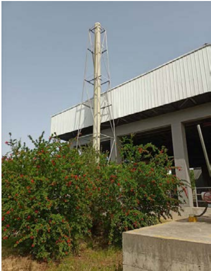
粗格栅及提升泵房排气筒
