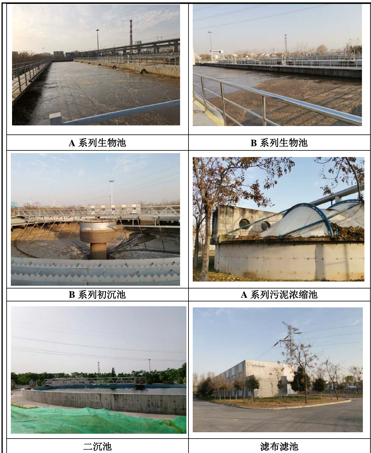
图 1-6 西安市第六污水处理厂现状
