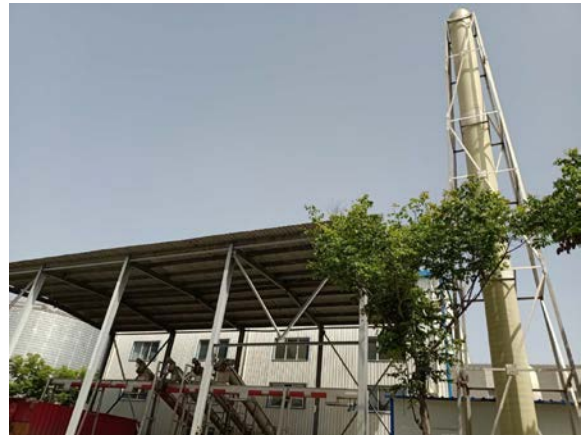
污泥脱水机房及排气筒
