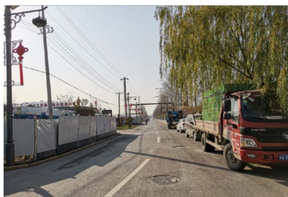
污水处理厂南侧道路
