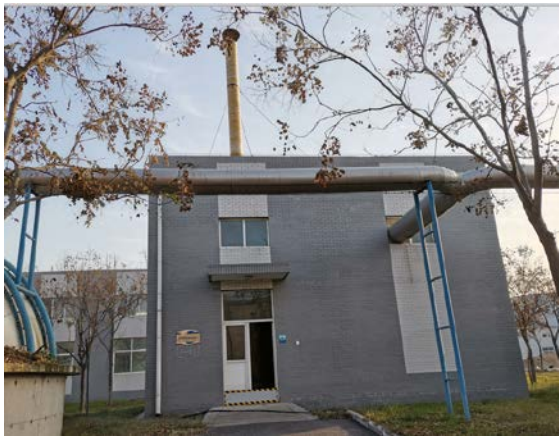
B 系列污泥浓缩池除臭间
