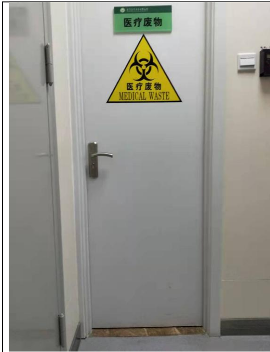
医疗废物暂存间
