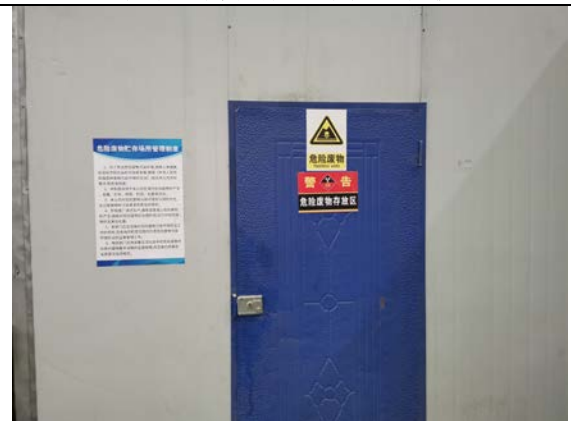
危废暂存间现状 (2)
