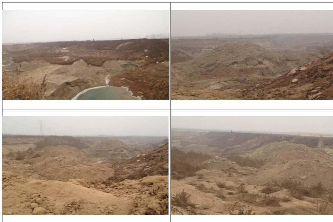
图 3.1-1 斗门镇南弃土场
