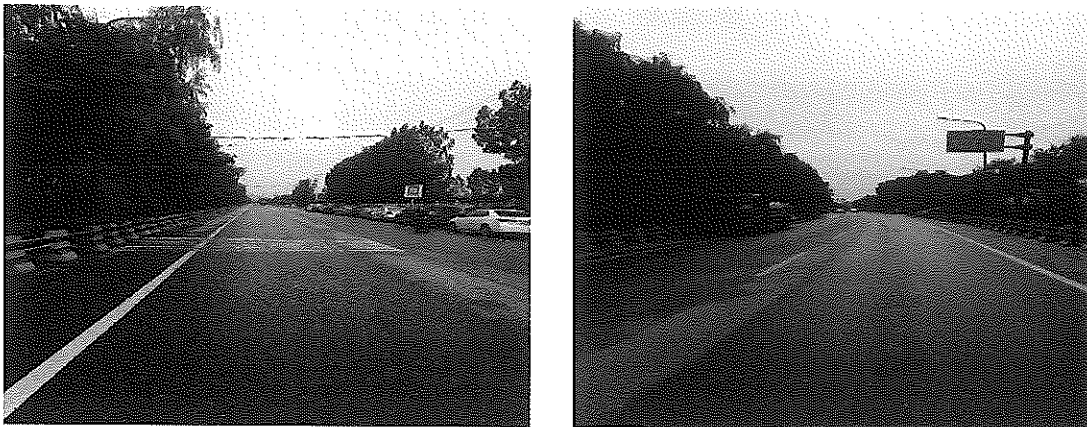
S1556845 热点网格排查整改照片
