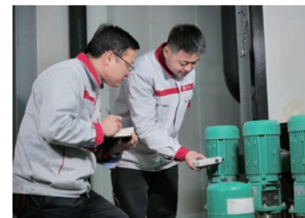
▲ 技术人员在进行设备检查调试
