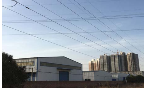
项目北侧厂房
