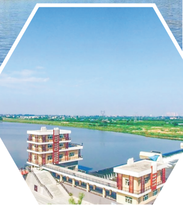
沣河 3 号橡胶坝
