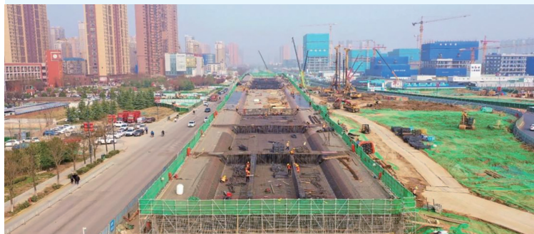
▲ 昆明路-连霍高速辅道快速化项目建设现场
