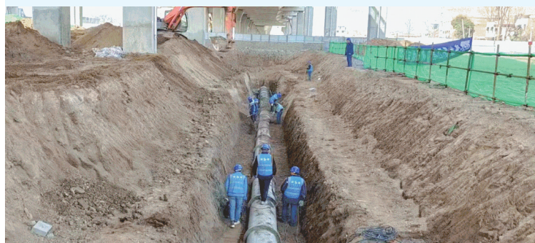
▲ 陈之路-科技二路建设现场
