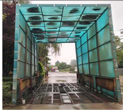
洗车台（下方为沉淀池）
